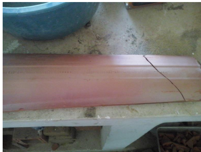
Figura 5 - Ruptura de telha de segunda linha 1.
