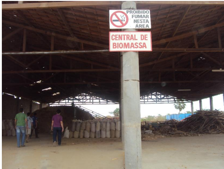
Figura 1. Central de biomassa da indústria.
