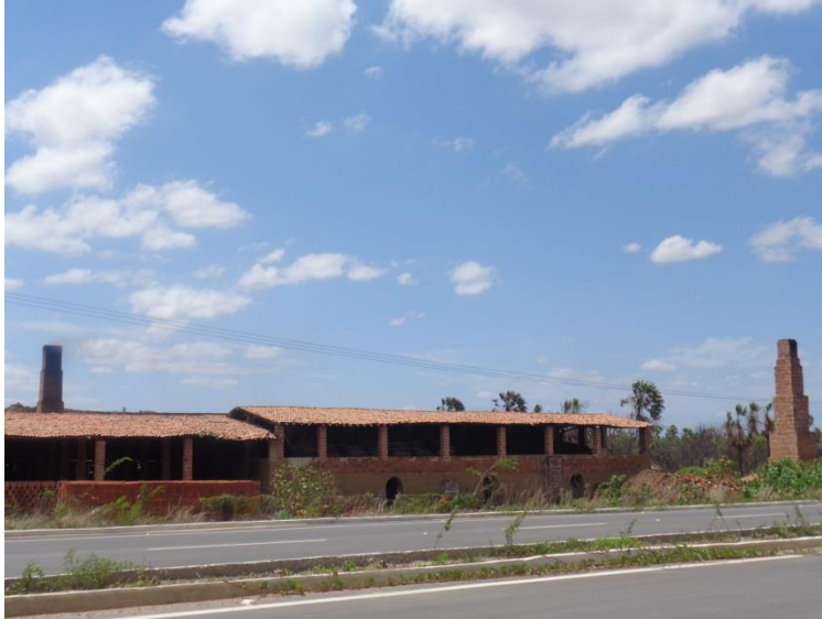
Figura 7. Chaminés com fornos.
