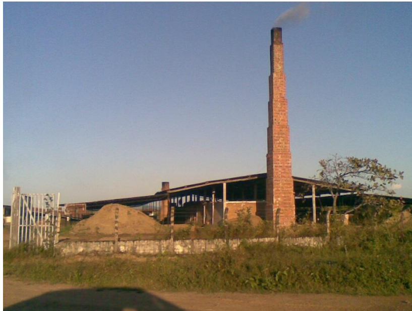
Figura 06. Chaminés bem próximas a rodovia.
