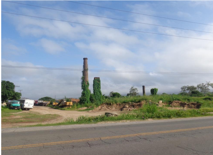
Figura 07. Chaminés bem próximas a rodovia.
