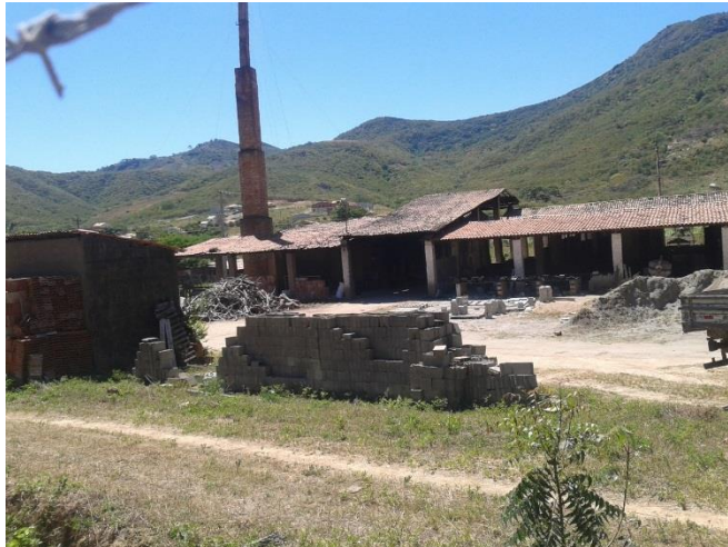
Figura 5. Galpões construídos de telhas e secagem natural.
