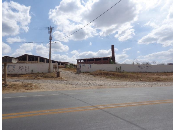
Figura 6. Entrada da cerâmica na margem da BR-222.
