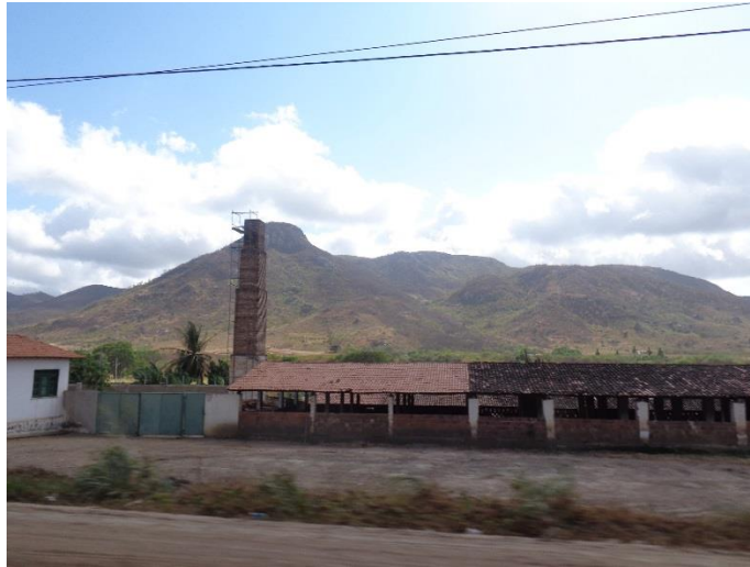
Figura 03. Aumento da altura da chaminé.
