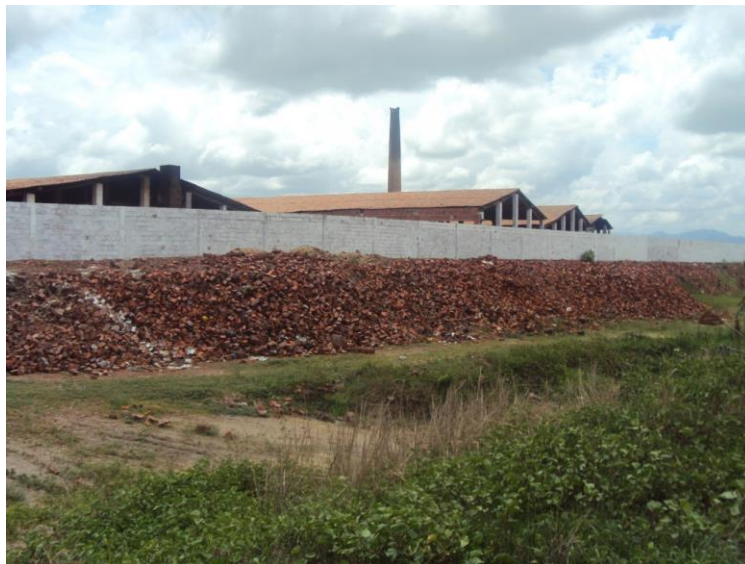
Figura 04. Estoque de resíduos que fica na margem da rodovia BR-020.
