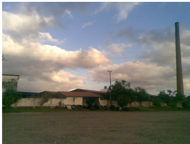
Figura 8. Chaminé e a cerâmica.
