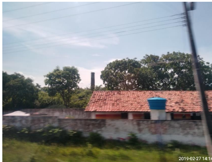
Figura 02. Chaminé por trás de uma edificação.
