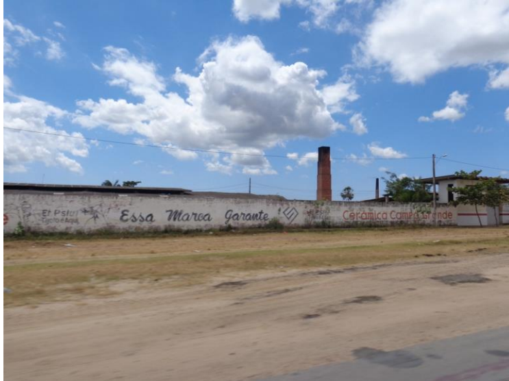
Figura 06. Chaminés bem próximas a rodovia.
