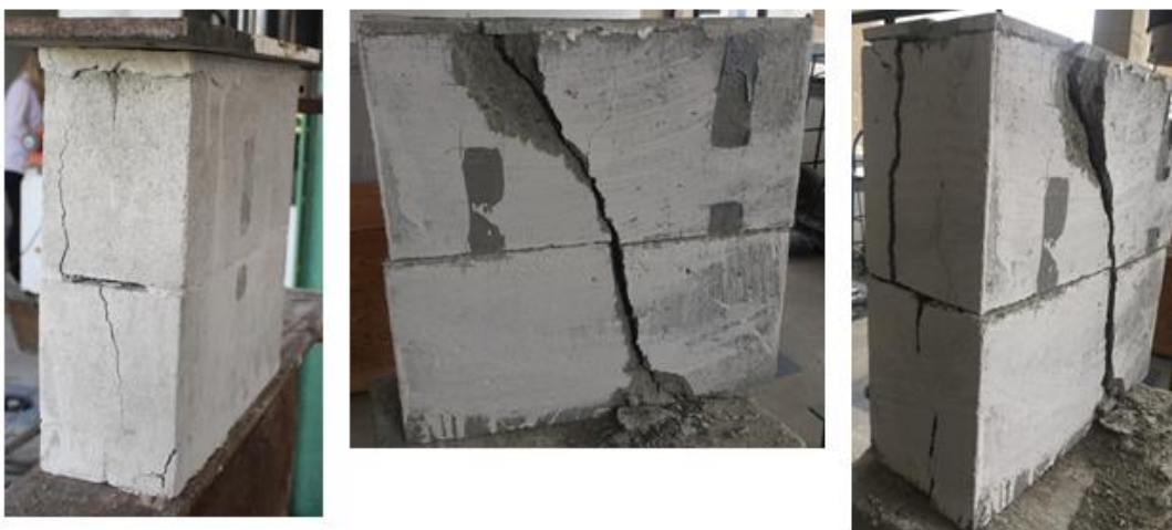
Figura 7 – Modo de ruptura dos prismas com argamassamento parcial.
