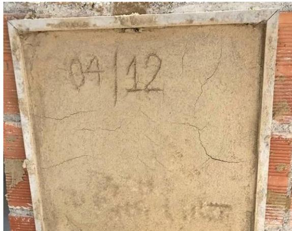
Figura 6: Presença de fissuras no revestimento F01.
